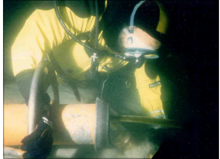
Arbeiten mit dem UW-Sauger
